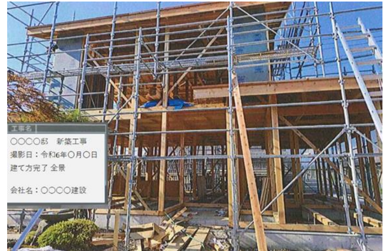
写真 建て方完了時の写真の例
