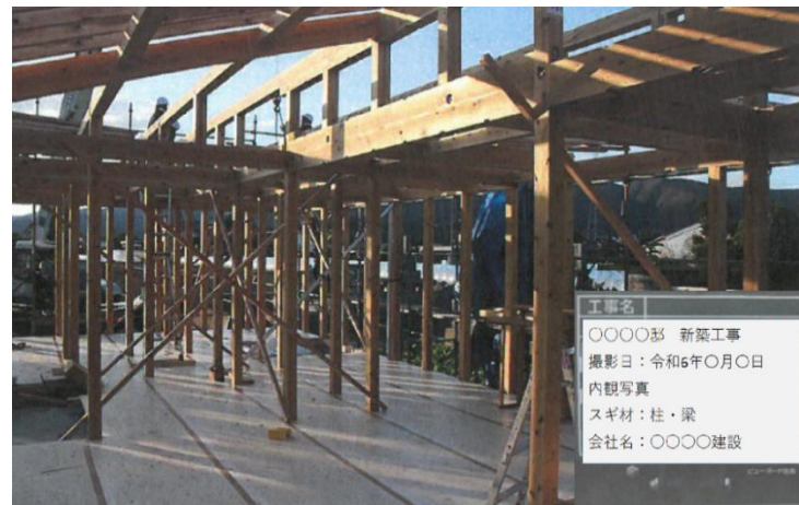
写真 施工写真の例
