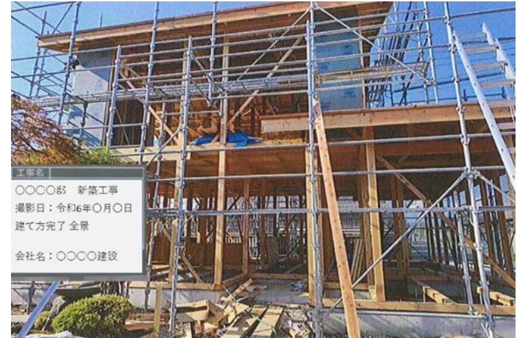
写真 建て方完了時の写真の例
